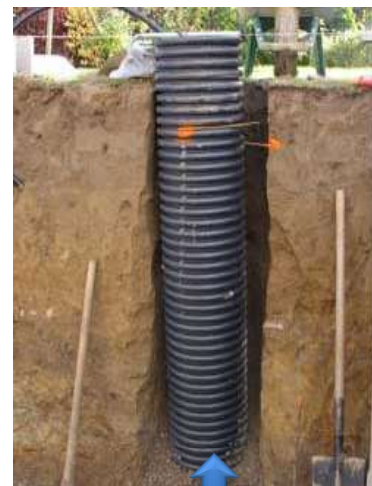
Puits d'assèchement
